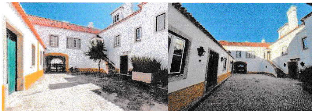
Antes da intervenção
